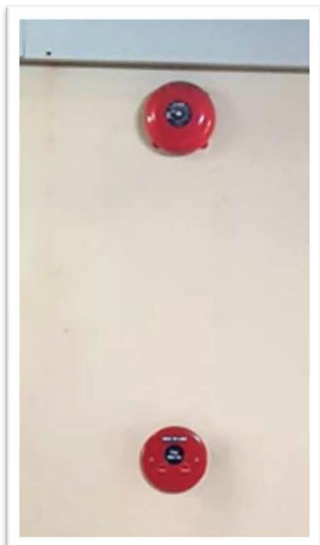
ที่แจ้งเหตุมือ และกริ่งดังเตือนภัย
